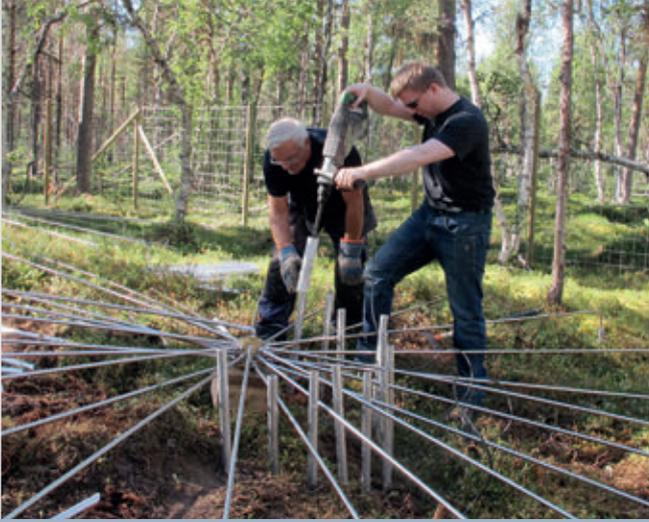
Instalación de un complejo de tubos en la estación infrasónica IS37, Bardufoss (Noruega).
