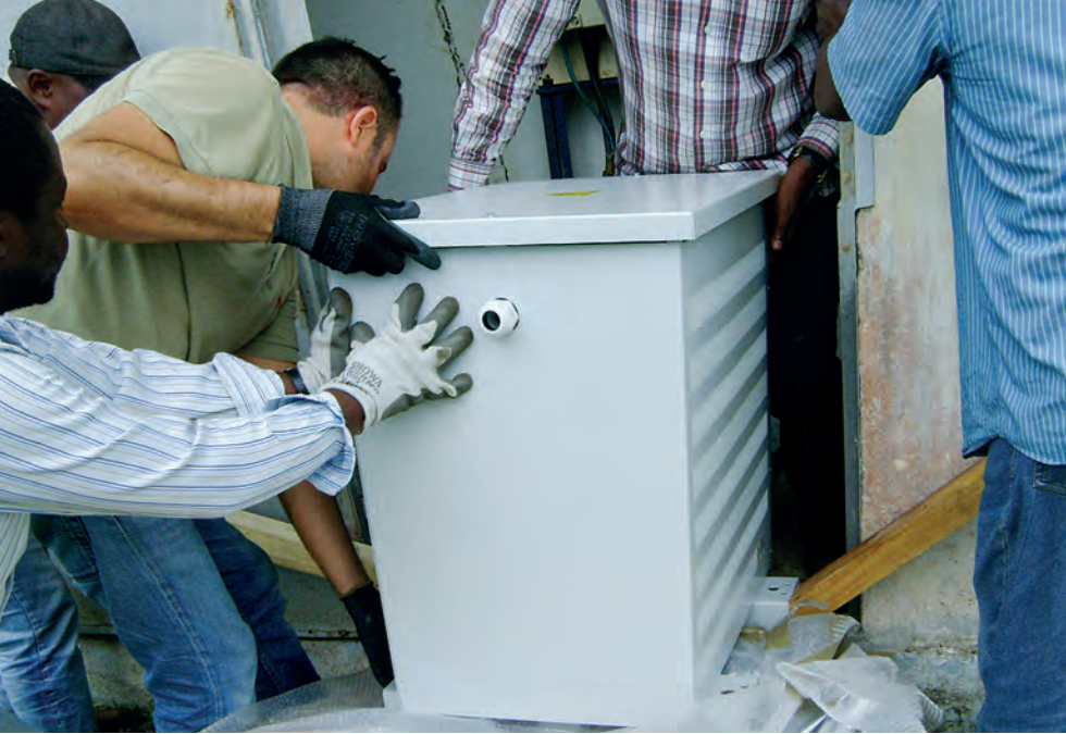
在埃及阿放射性核素台站 RN13 安装一个新的变压器（喀麦隆）
