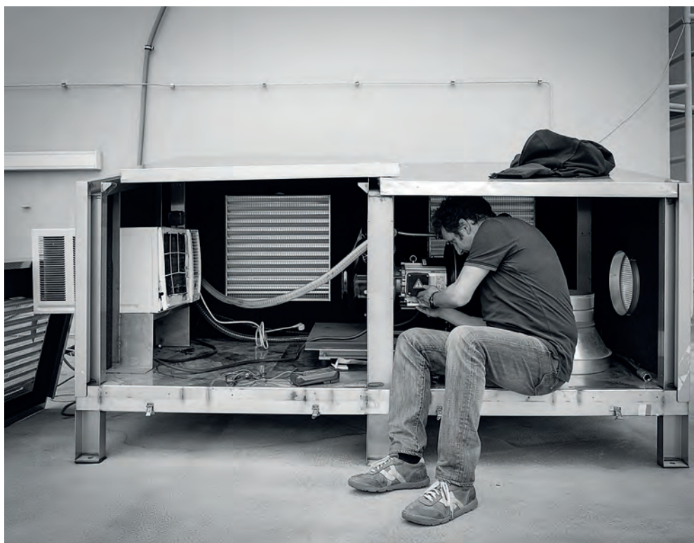
维修维也纳国际中心惰性气体系统压缩机
