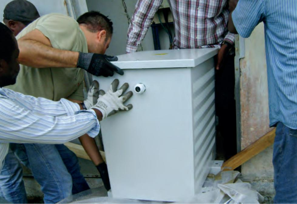
Установка нового трансформатора на радионуклидной станции RN13, Эдеа (Камерун)
