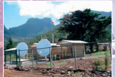
جزر خوان فيرنانديز (شيلي). الموقع المشترك للمحطة الصوتية المائية HA3 والمحطة دون الصوتية IS14. ويظهر في الصورة الداخلية المرفق الشاطئي للمحطة HA3 ومرفق التسجيل المركزي للمحطة IS14 قبل أن يدمرها حدث تسونامي في عام ٢٠١٠.
