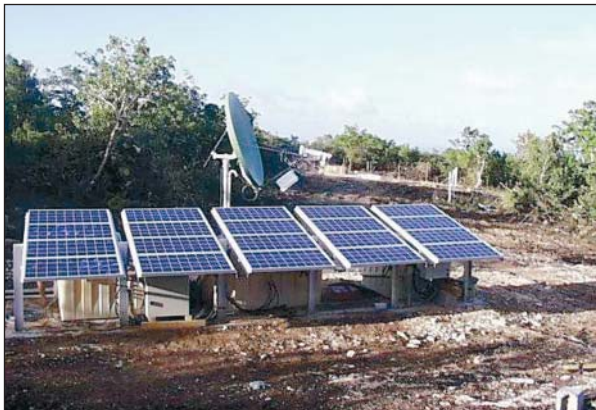
1. Солнечные панели, аккумуляторные батареи и спутниковая антенна южного элемента станции НА5, Гваделупа (Франция), первой гидроакустической станции Т-фазы, получившей сертификат (январь 2002 года).
